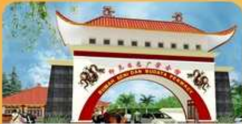
Pintu Gerbang Dan Pos Keamanan
